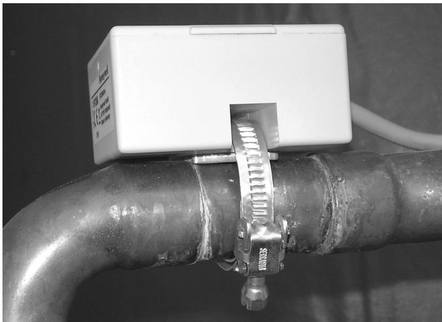
Anlegesensor hinter dem Mischventil im Heizkreis.
