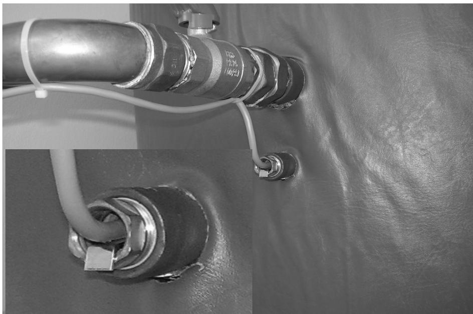
Temperatursensor des oberen Teils des Behälters PF (VE), oder Sensor des Warmwasserspeichers im kombinierten Warmwasserwärmer eingesteckt in Schutzhülse.
