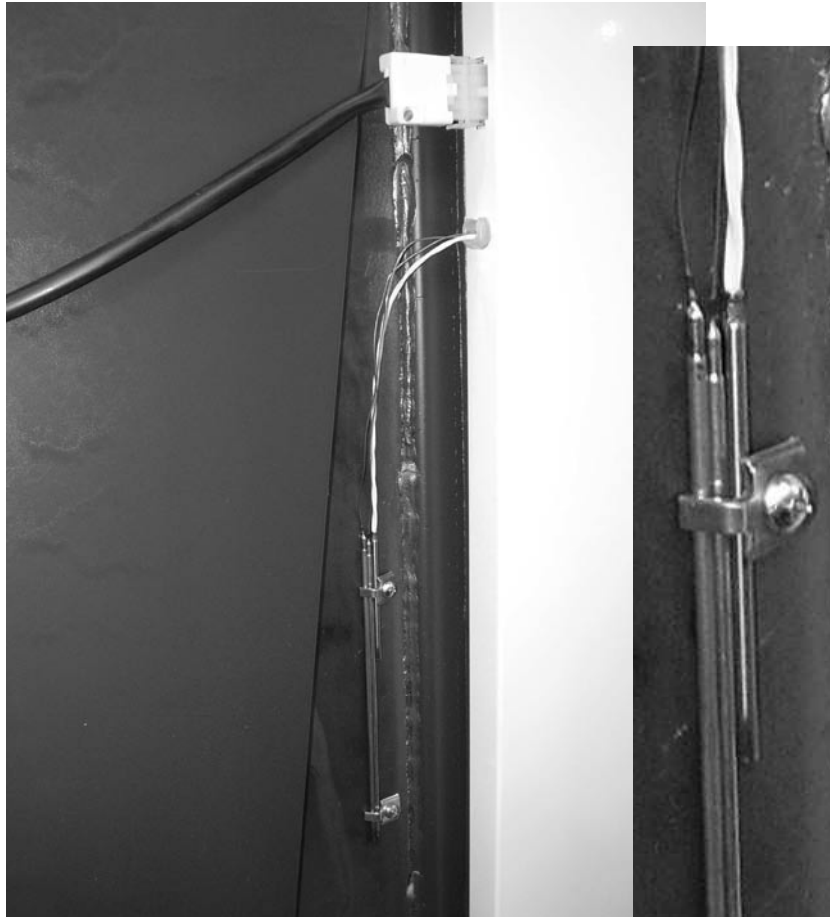
Angelegter Abgassensor am Kesselrauchabzug ( DCxxGSE, DCxxGSX, DCxxRS ), zugegeben zum Thermostatsensor ursprünglicher elektromechanischer Kesselregelung !!! Dieser Sensor muss mit Isolierung gedeckt werden !!!
