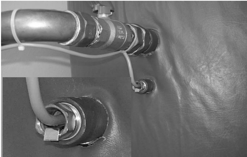
Temperatursensor des oberen Teils des Behälters PF (VE), oder Sensor des Warmwasserspeichers im kombinierten Warmwasserwärmer eingesteckt in Schutzhülse.
