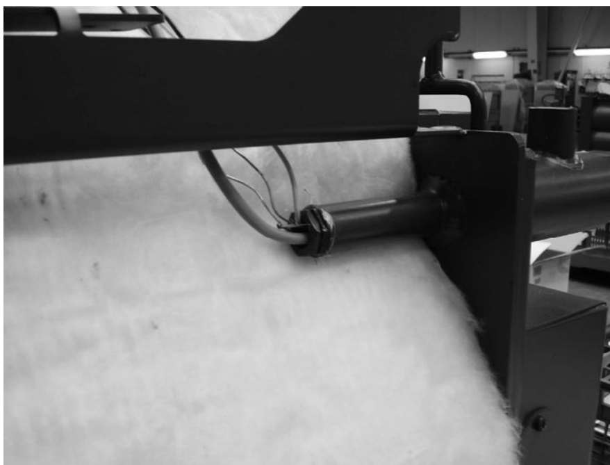
Sensor der Kesseltemperatur WF in Schutzhülse, zugegeben zu sonstigen Sensoren der Thermostate ursprünglicher elektromechanischer Kesselregelung
