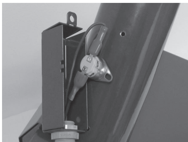
Abb. 10 - Sicherheitsthermostat am Rohr für Pelletzufuhr 95°C
