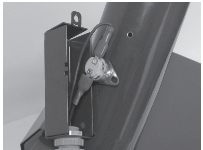
Abb. 10 - Sicherheitsthermostat am Rohr für Pelletzufuhr 95°C
