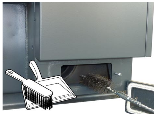
Vorführung der Reinigung des Rauchkanals mit Drahtbürste.
